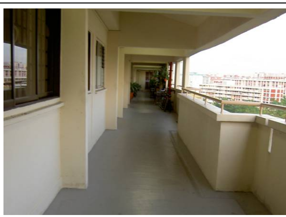
照 30 組屋樓層中通達各戶的長廊
